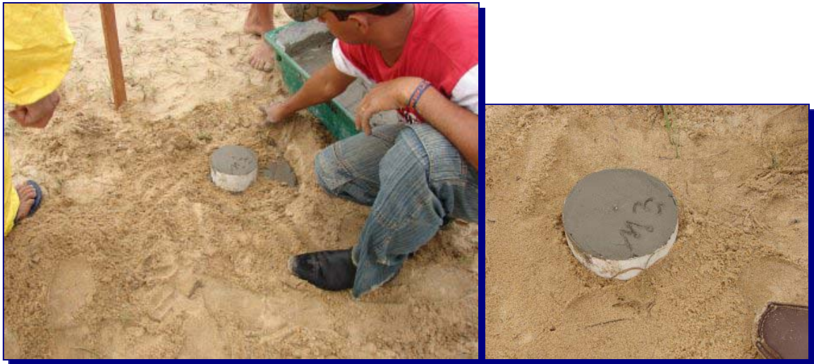
Foto 14: Marco de referência de início do perfil M03, sendo instalado e no detalhe a posição final deste mesmo marco, depois de pronto e enterrado (Foto tirada em 13/11/2007).
